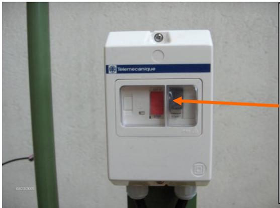
La mise en route des moteurs se fait en appuyant sur le bouton noir des boîtiers électriques.
