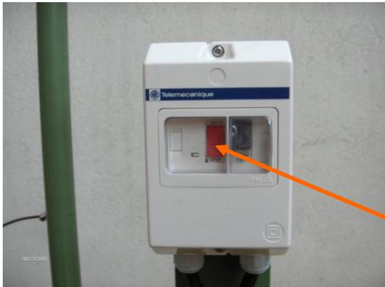
Pour arrêter les moteurs électriques il faut appuyer sur le bouton rouge des boîtiers électriques
